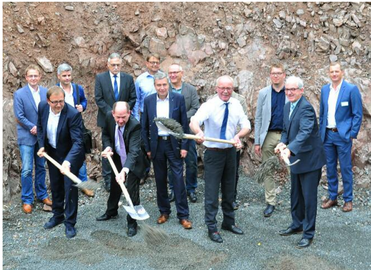
Spatenstich für den Neubau des Schulzentrums für Pflegeberufe im August 2017
